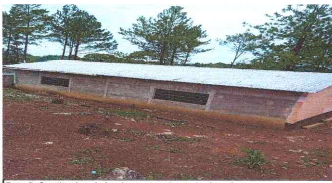
Foto 5: Sustitución de laminas en mal estado de aulas
