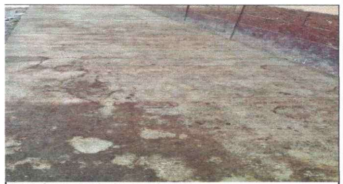
Foto 6: Sustitución de piso en mal estado
