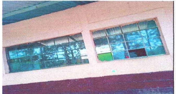
Foto 2: Sustitución de vidrios en mal estado
